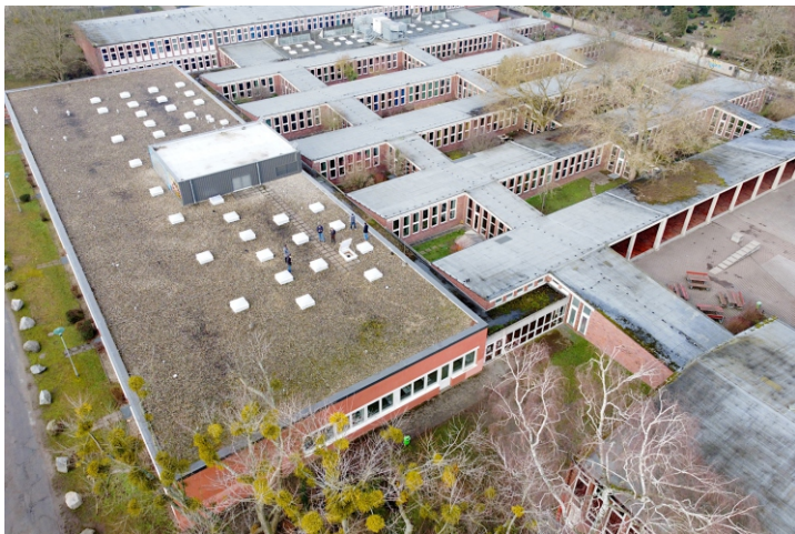
Das Dach eignet sich gut für eine nach Ost und West ausgerichtete PV-Anlage
