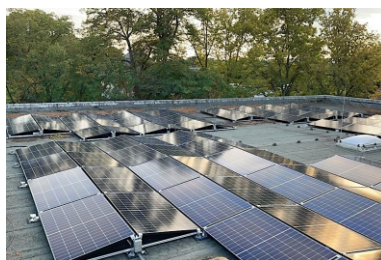
Die Module werden wie hier auf der Käthe-Kollwitz-Schule in Frankfurt auf dem Dach angebracht.
